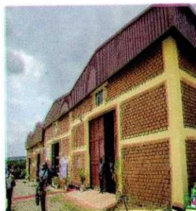
NBBRI POZZOLANA PLANT, OTA
