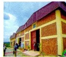
NBRRI POZZOLANA PLANT, OTA
